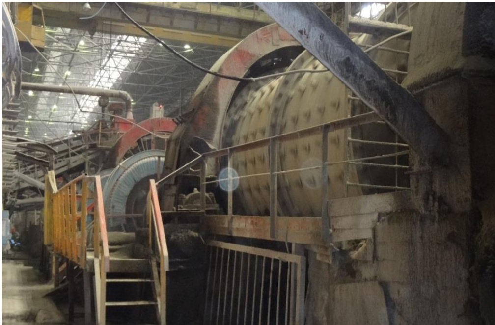
Рисунок 1.2 - Участок помола шаровыми мельницами на БГМК
