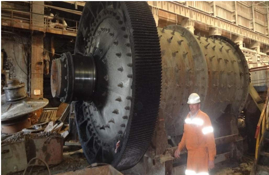
Рисунок 1.3 - Шаровая мельница при капитальном ремонте
